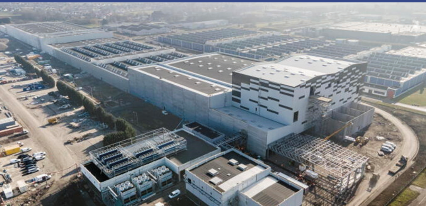
Usine de batteries de Douvrin © Simone Perolari/REA
